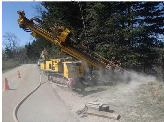
Un forage en diamètre 110 mn est réalisé, le but est de capter la circulation souterraine et de la diriger en pied de falaise vers le bassin de décantation (excentré de quelques mètres de la sortie de la source). Le premier essai passe juste à côté, on vérifie les réglages d'angle et à la seconde tentative : Bingo ! Le forage de 36,4 m sort exactement à l'endroit prévu et l'eau jaillit à plein tube ! Une belle réussite !
