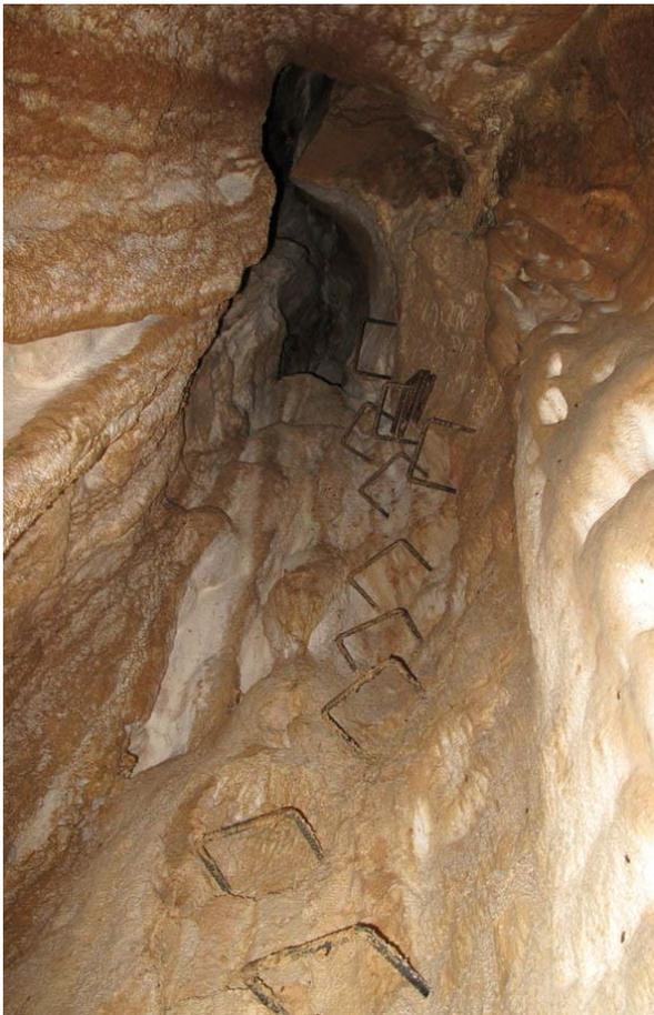
Aucune idée sur les auteurs de ces aménagements mais un tel déploiement de moyens et d'énergie pour un si piètre résultat laisse perplexes les spéléos que nous sommes ! L'emploi d'un perforateur avec mèche de diamètre 14 et le cintrage parfait des échelons laissent entrevoir ici l'emploi de matériel professionnel.
